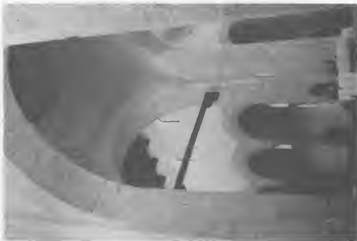
Foto. 12. — Gerace, cattedrale. Il quadrato di crociera con la calotta impostata su cuffie angolari a rincassi multipli.
